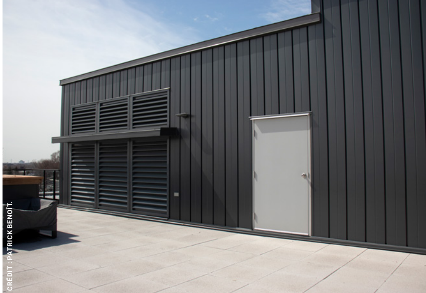
Les pompes à chaleur VRV sont installées dans un local mécanique. Cela permet d'éliminer l'influence du climat extérieur hivernal avec un chauffage d'appoint assuré par un aérotherme au gaz naturel.
