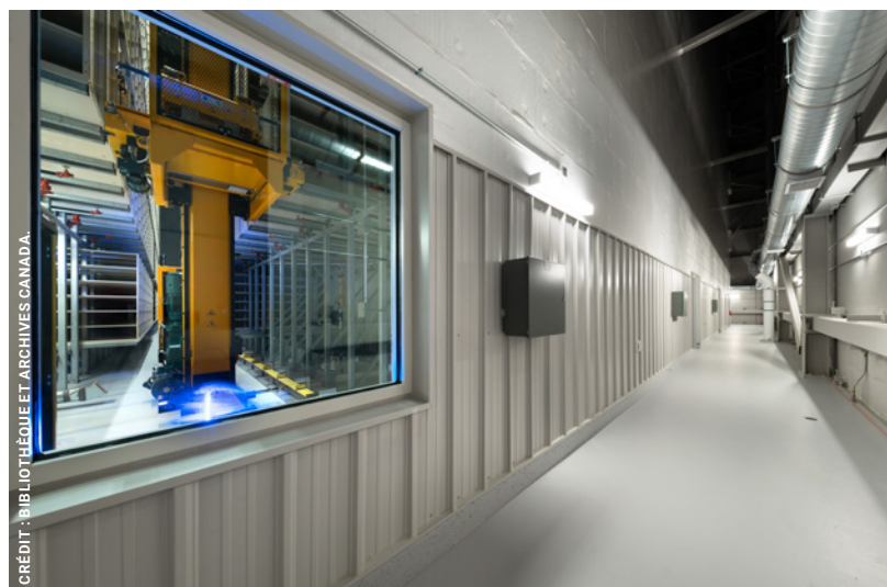
Le système robotique SRRA sur rail fonctionne dans l'obscurité et restreint le nombre d'ouvertures des chambres fortes pour économiser l'énergie et maintenir les conditions de préservation optimales.
