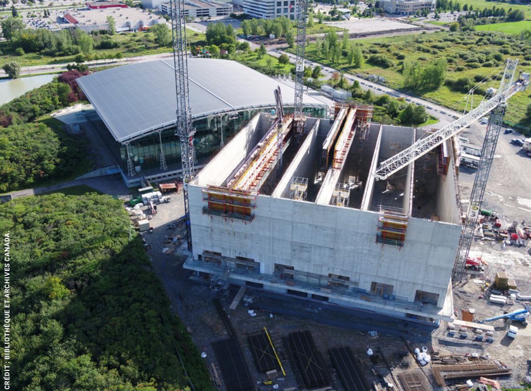
Construction de l'entrepôt et de ses six chambres fortes en septembre 2020. Notons que le bâtiment a été construit en angle par rapport au premier centre d'archivage.
