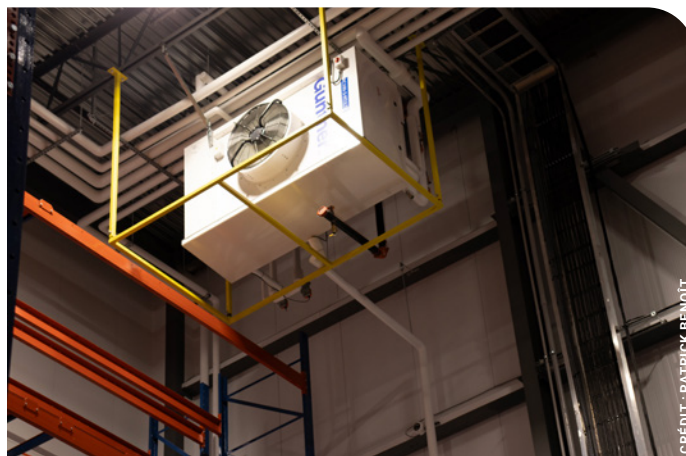
Un des évaporateurs refroidisseurs installés dans l'immense congélateur.
