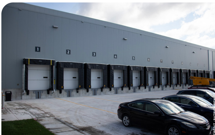
Le nouveau congélateur de Congebec est muni d'un quai de chargement donnant accès à 30 portes.
