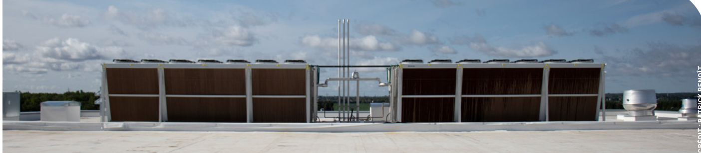
Deux refroidisseurs de gaz adiabatiques installés sur le toit rejettent la chaleur à l'extérieur.
