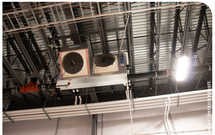
Des refroidisseurs sont orientés de façon à éviter la stratification de l'air.
