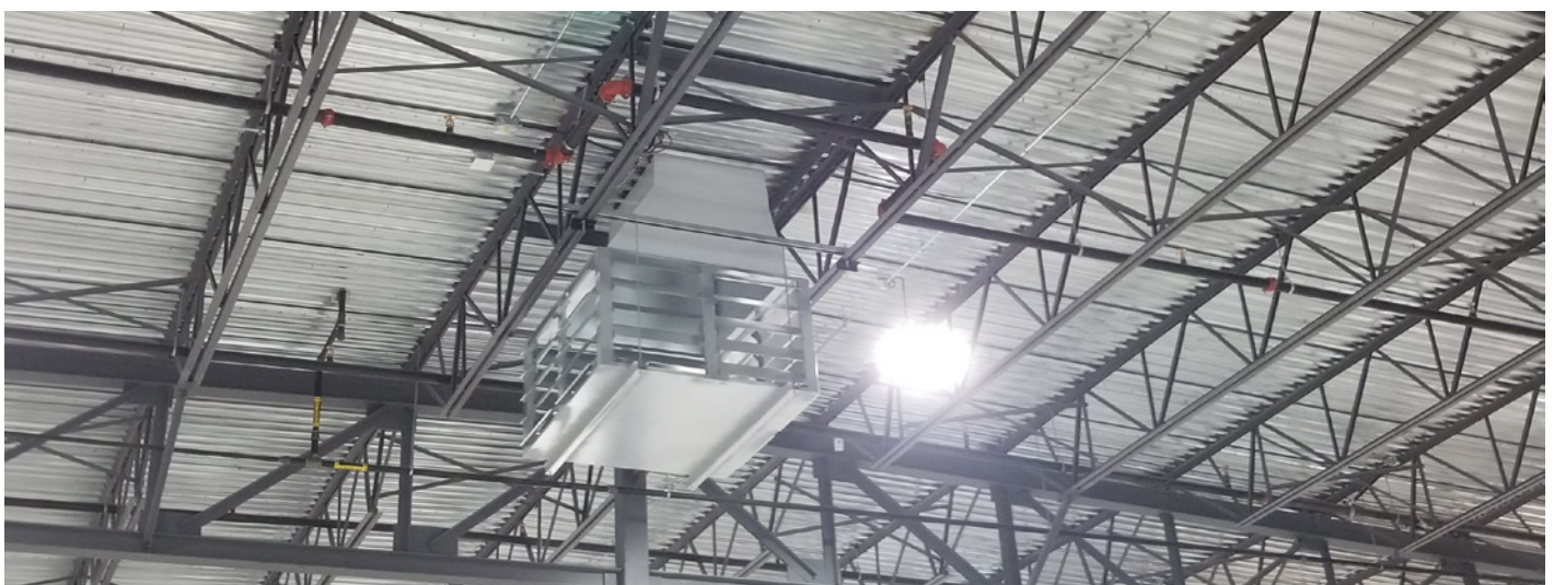
La ventilation par dilution d'air consiste à faire circuler beaucoup d'air dans l'espace de production dans le but de diminuer la température.
