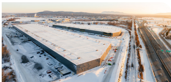
Vue aérienne des deux énormes bâtiments de l'Écoparc dont plusieurs locaux seront loués à des entreprises industrielles. Colabor et Master seront les deux premières à s'y loger.
