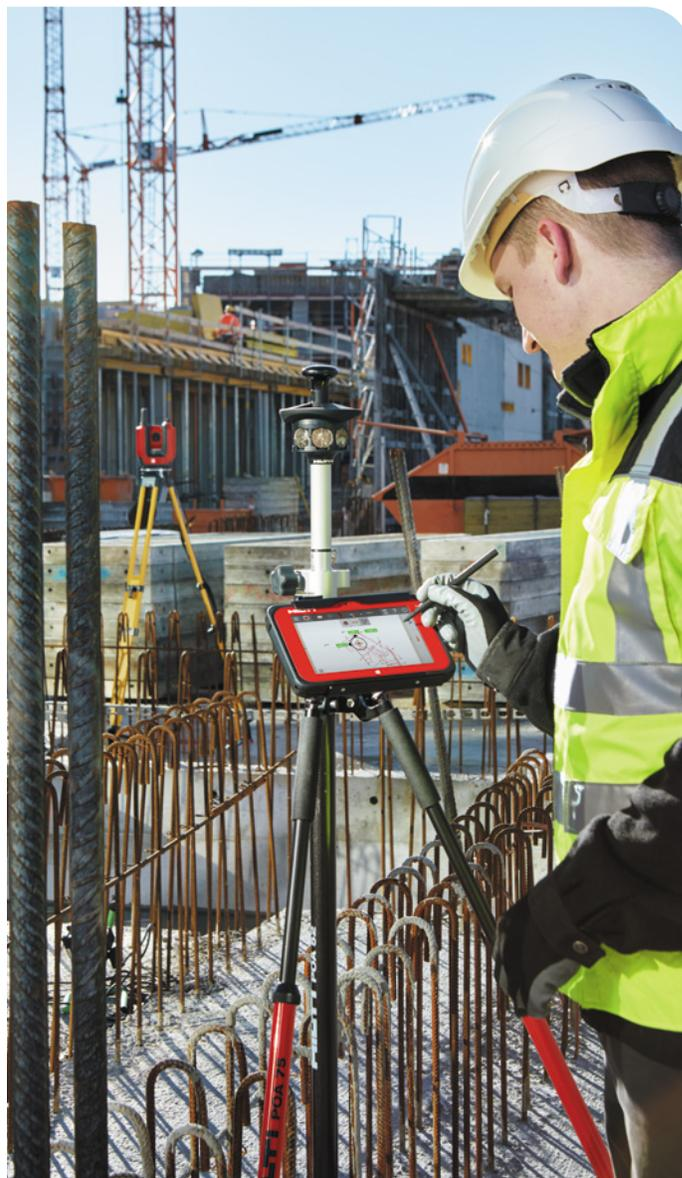
**La station totale est connectée en Wi-Fi à une tablette pour visualiser les points d'implantation et les relevés des travaux effectués sur le chantier, puis les superposer sur le plan afin de vérifier leur conformité ou déceler les erreurs.**
